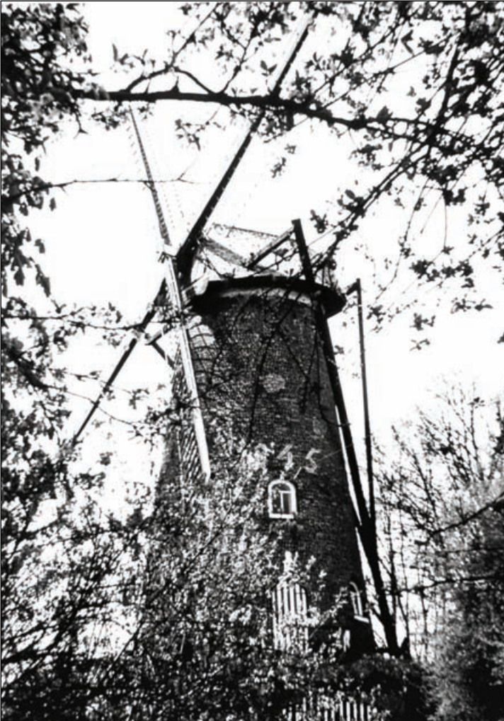
Na de restauratie van 1962. Let op de (opgekalkte) cijfers die het jaartal 1845 vormen. Collectie Ons Molenheem
