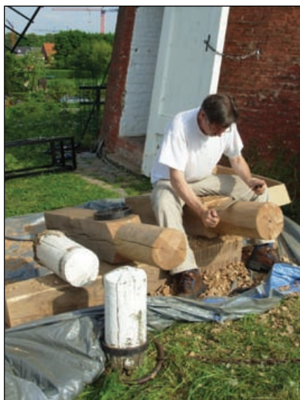
2009. Van links naar rechts: Gust Smits bij het verwijderen van een oude kruipaal. Jan Nys bij de vervaardiging van kruipalen. De nieuwe kruipalen. (Foto's Luc Verachtert)
