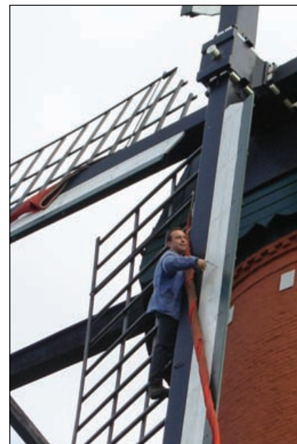
Luk Kegeleers draait losse bouten van de windplanken vast. 2006. (Foto Luc Verachtert)
