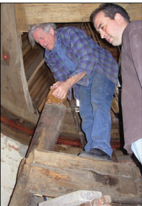
2006 Herstelling van de vangbalk:
