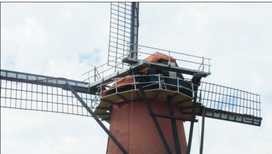
2011 Links: Molenmaker Adriaens neemt de kap onder handen en gebruikt de oude stellinggaten. Rechts: De herstelde kap vanuit de kerktoeren van Oelegem.
